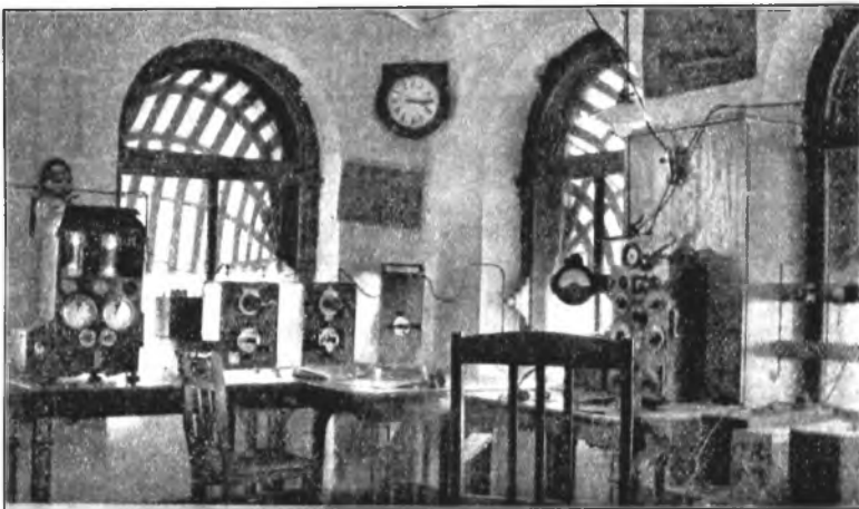
Het inwendige van het radiostation.
